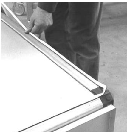
1. Kiinnitä osaan tiivistenauha. Kuva 7.11.
