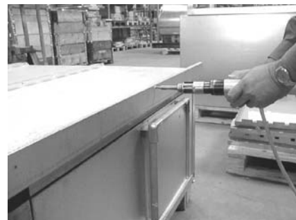
9. Kiinnitä kattolevyt suojaprofiileihin. Kuva 7.19.
