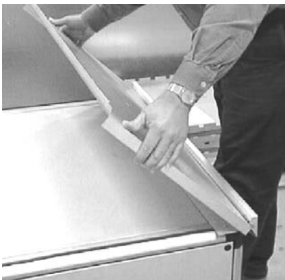
5. Aseta kattolevyn ylöspäin taivutettu reuna suojaprofiilin alle ja laske kattolevy osan päälle. Kuva 7.15.
